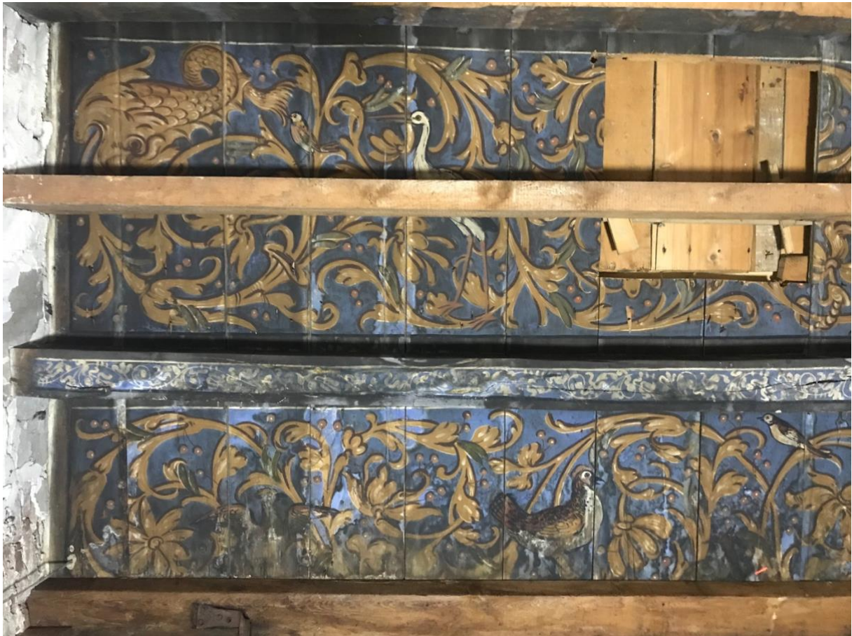
Afb.5 Detail van het blauw beschilderde plafond met in de 20 ste eeuw toegevoegde balken. Foto auteur.
